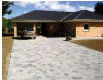
En langtidsholdbar indkørsel med armeringsnet.
